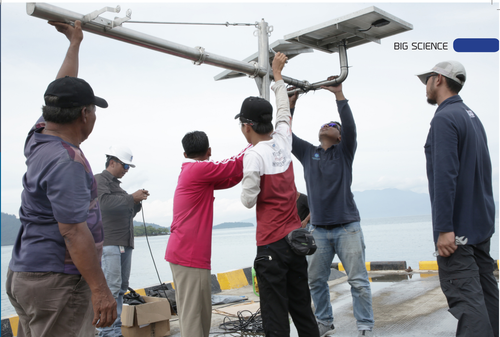
Pemasangan Tide Gauge di sekitar Anak Gunung Krakatau, Pulau Sebesi pada 24 Januari 2019.
