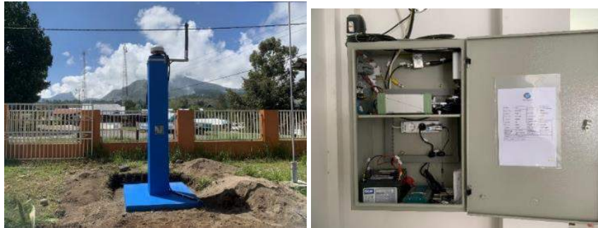
Gambar 14. Hasil Pembangunan Pilar dan Instalasi Ina-CORS CLBT
