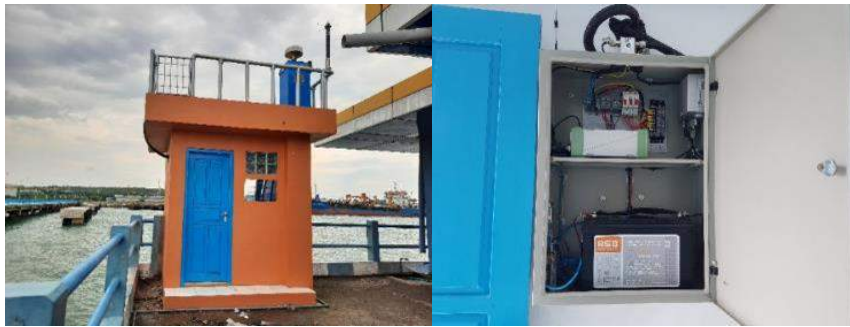
Gambar 15. Hasil Pembangunan Pilar dan Instalasi Ina-CORS CPRC
