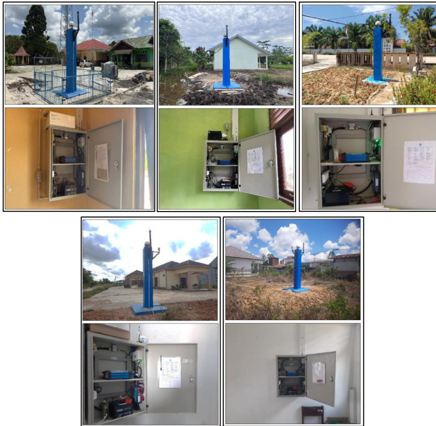
Gambar 6 Hasil Pembangunan Pilar dan Instalasi Ina-CORS Pilar Tipe A - Tinggi 3 m
