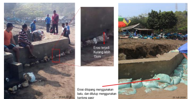
Gambar 6. Penanganan kerusakan erosi akibat gelombang pasang di Pantai Baron, Gunung Kidul.
